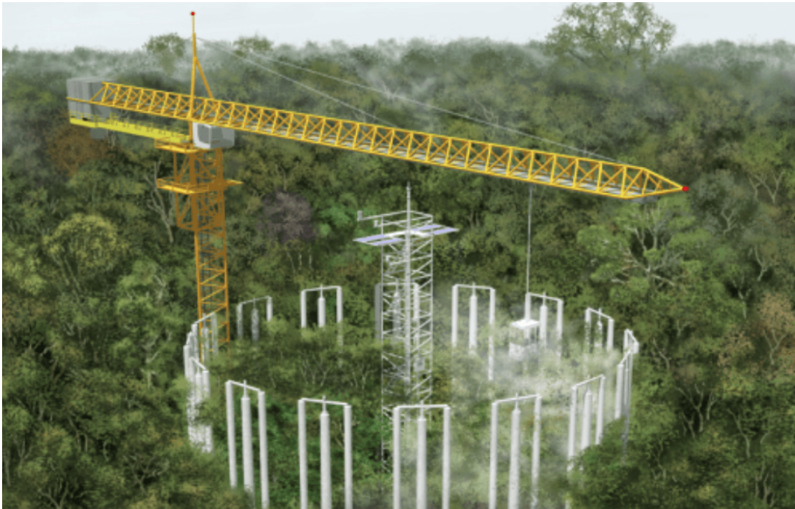
Figura 2 – Torres usadas pelo AmazonFACE, ainda em fase de construção
